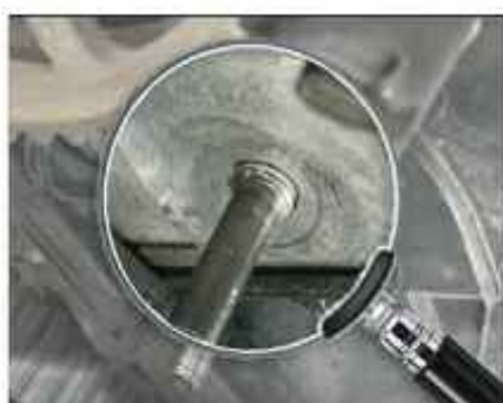
Fig. 1: El espárrago no está roscado correctamente.
