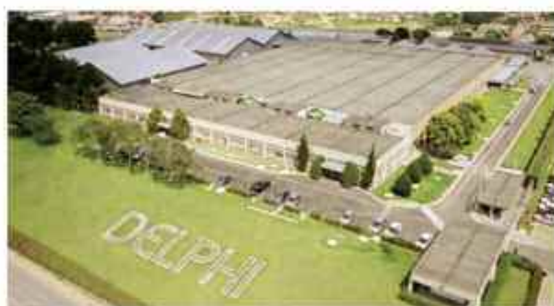
Fábrica Delphi en Paraisópolis (MG) Donde se producen 1.000.000 cables de bujías/año.
