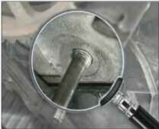
Fig. 1: El espárrago no está roscado correctamente.
