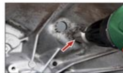
Fig. 5: Ampliación de los orificios con un taladro
